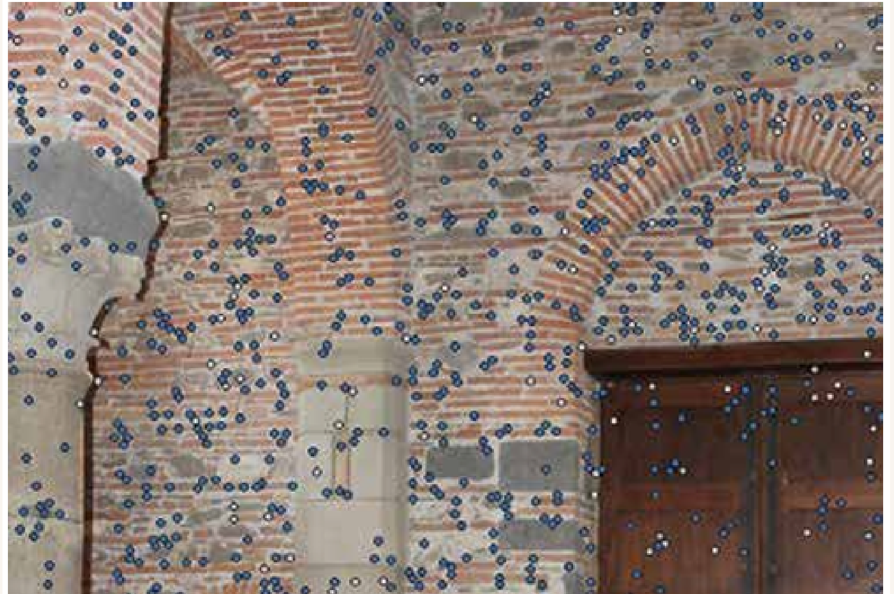
Corrispondenze di immagini, o punti di collegamento, rilevate su una foto dell'interno di una chiesa
